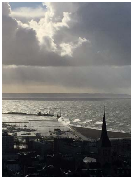
Digue Sud – Port du Havre
