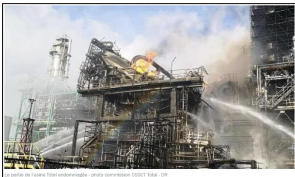
La partie de l'usine Total endommagée - photo commission CSSCT Total - DR
