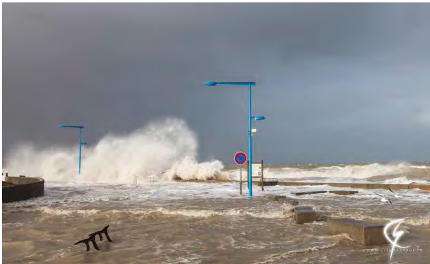
Rupture de la digue d'Asnelles en janvier 2018 © Ciel Sauvage
