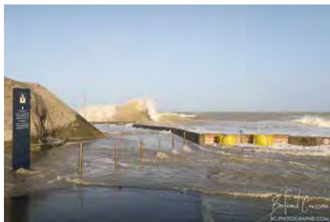
Rupture de la digue d'Asnelles en janvier 2018 - © Bertrand Cousseau
