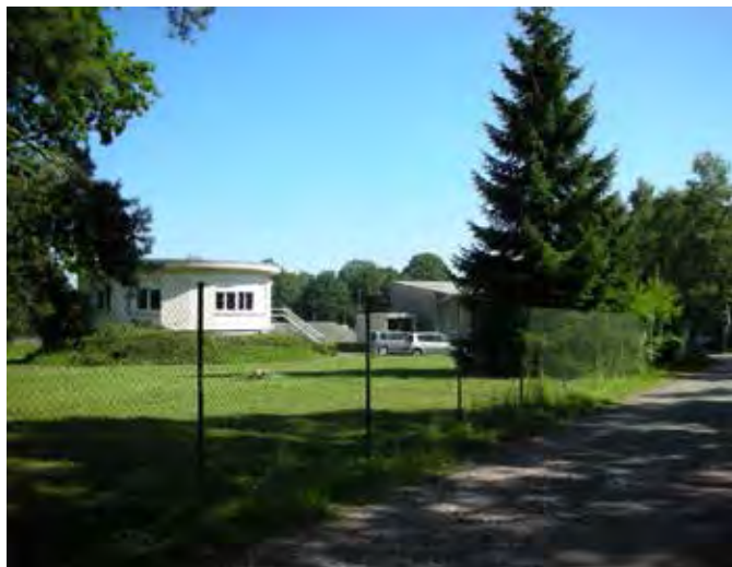
dépôt EPC de Boulon
