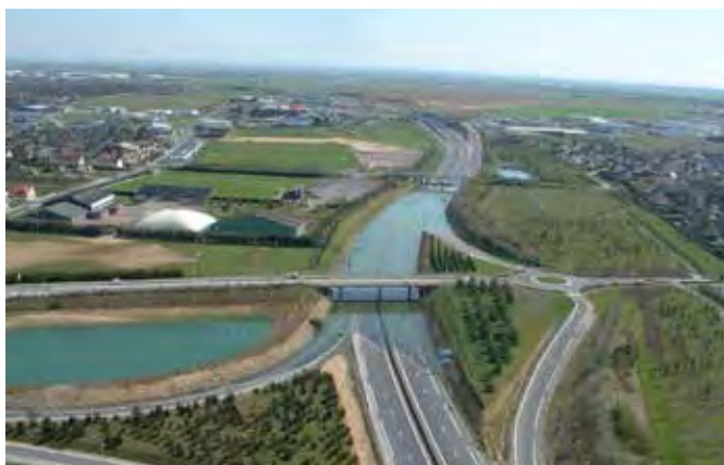
Remontée de nappe sur le périphérique de Caen en avril 2001
