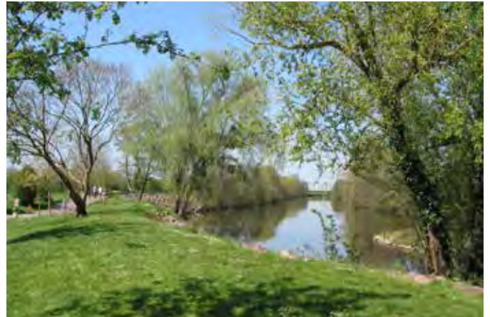
Digue de l'Orne à Fleury-sur-Orne (crédits photo : DREAL Normandie)
