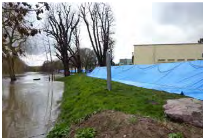
Digue de protection à Louvigny
