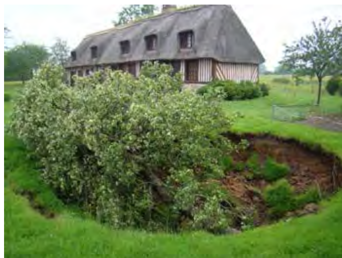
Effondrement à Formentin en 2016
